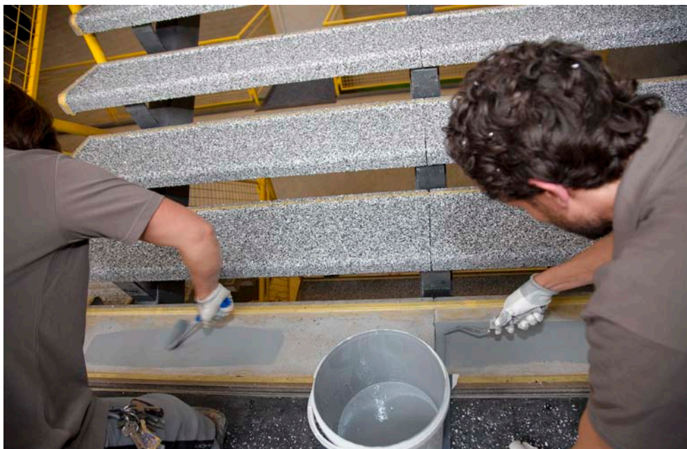
De grijsgekleurde kleeflaag wordt trede voor trede aangebracht, waarna de vlokken worden ingeblazen.
